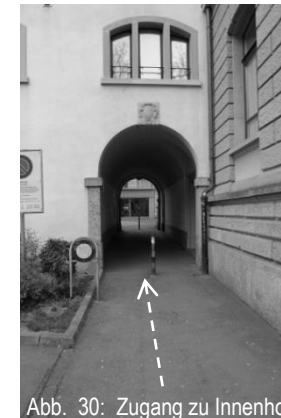
Abb. 30: Zugang zu Innenhof
