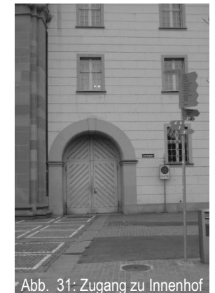
Abb. 31: Zugang zu Innenhof
